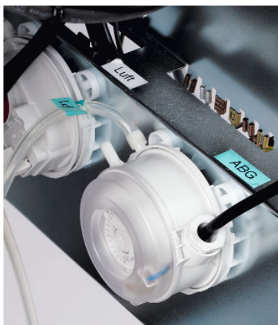
Des pressostats air et fumées apportent une grande sécurité
