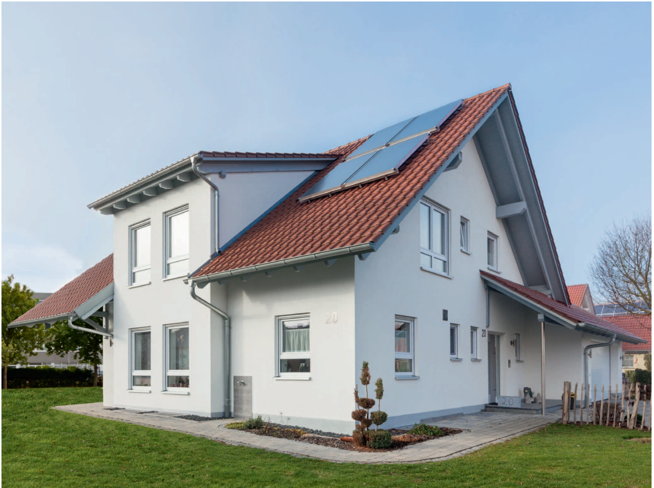
Kollektoranlage zur kombinierten Trinkwassererwärmung und Heizungsunterstützung
