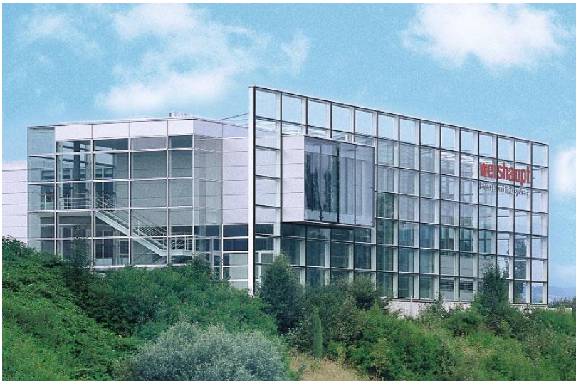
Weishaupt | Schulungs- und Verwaltungsgebäude in Geroldswil (ZH)
