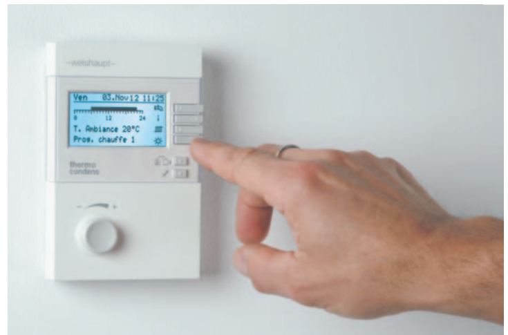
Drücken und Drehen beschreibt das logische Bedienkonzept bei der Fernbedienstation WCM-FS.
